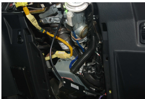
ライトスイッチのコネクターは狭くて外せないなのでハーネスで分岐します。キーシリンダーの上側通っているプラスチックのジャバラが付いているハーネスの、ジャバラを取ります。外側にビニールテープが巻いてあるのでほどけば外れます。
