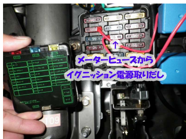
電源取りだし用ヒューズを使用して接続
